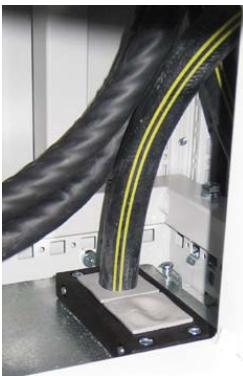
Abb. 10: Durchführung für Ablaufschlauch im Schrankboden
